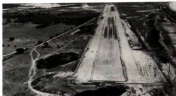
Ampliación y rehabilitación de la pista del aeropuerto federal de Mazatlán en 1962, trabajos realizados para hacer posible la operación de aviones jet.
