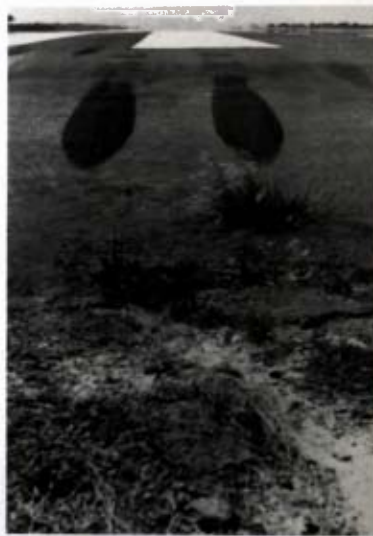
Marcas de toma de contacto antes del peine de la pista 10/28 del aeropuerto de Guadalajara, que tenía 2 200 m de longitud en 1966. La construida en 1968 tiene 4 000 m.
