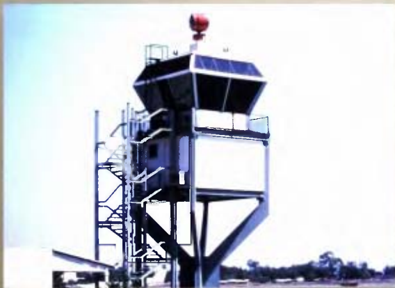
Torre de control prefabricada y desarmable que puede ser utilizada como torre tipo en aeropuertos de corto y mediano alcance. Actualmente sigue operando en Guaymas.
