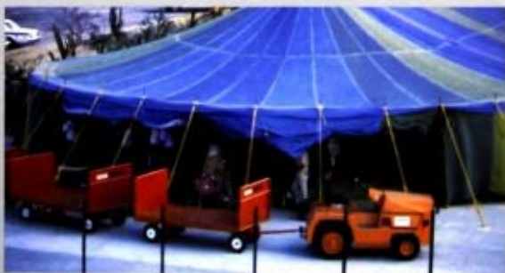
Edificio provisional desmontable de estructura tubular y cubierta de lona, diseñado y construido por ASA en 1980 para el aeropuerto de San José del Cabo.
