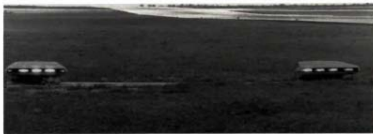
En la mayoría de los aeropuertos del país se instalaron modernos sistemas de ayudas visuales, como los VASI que aparecen en esta imagen.
