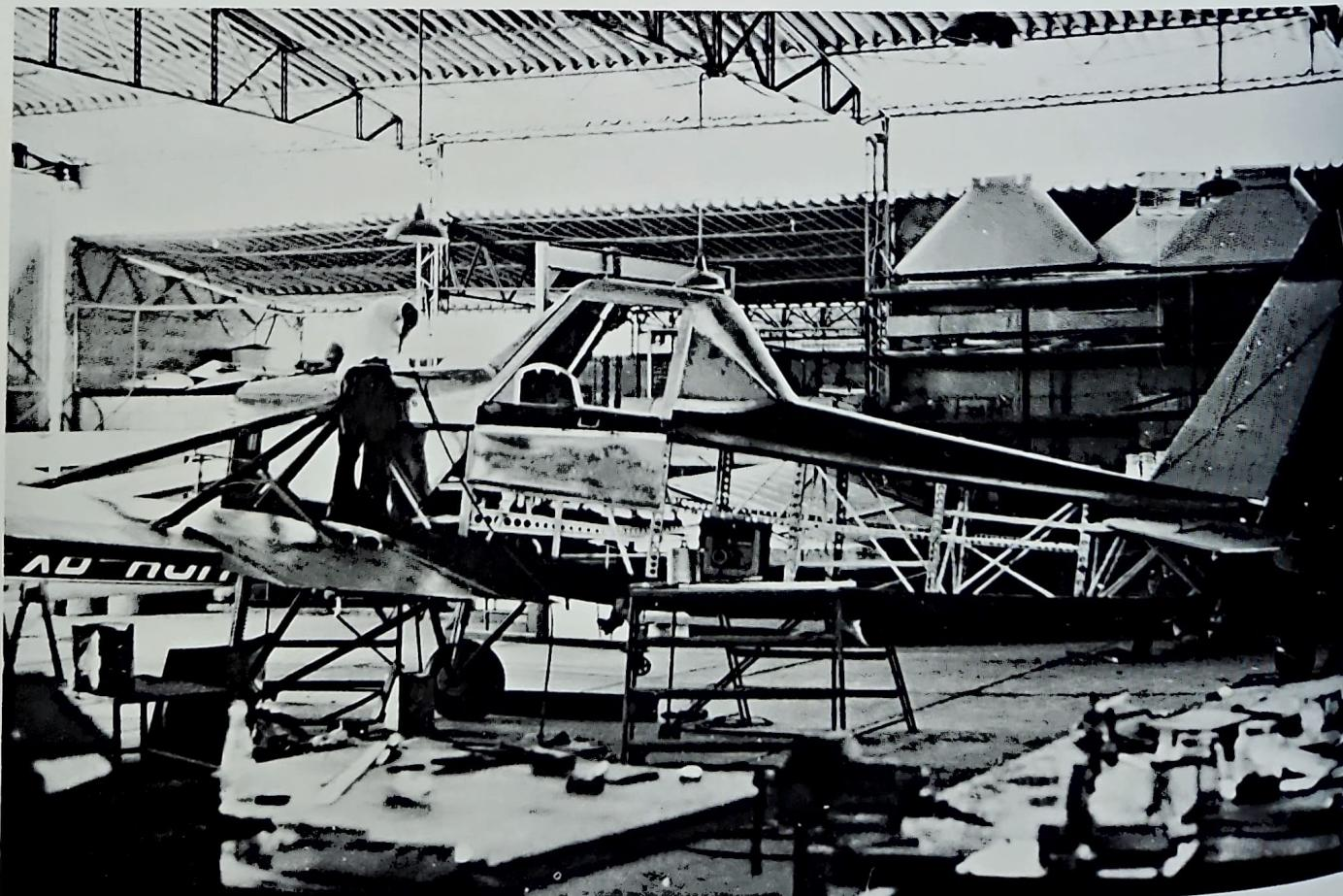
Armado de un avión fumigador Tauro.
